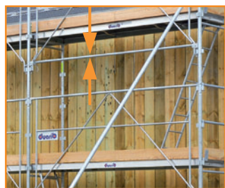
Travée d'accès avec lisse de protection au-dessus du garde-corps.
